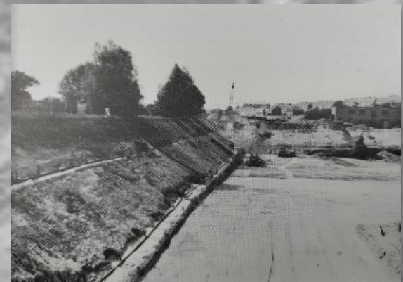
Aanleg spaarkom Diegem
