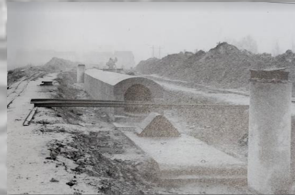
Aanleg collector Sint-Lambrechts-Woluwe
